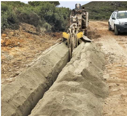
■ Figure 5. Creusement de tranchée en terrain amiantifère
